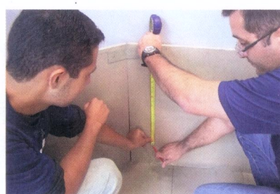
Figura 5 – Marcação do nível de instalação
