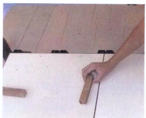
Figura 15 – Verificação do nivelamento das placas
