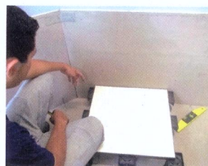
Figura 12 – Posicionamento da primeira placa
