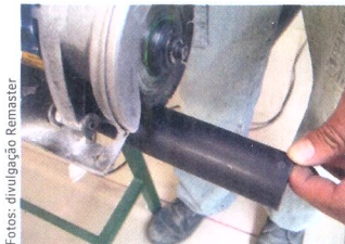
Figura 6 – Corte do tubo de PVC
