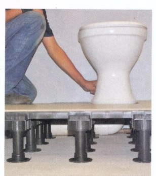
Figura 21 – Instalação do vaso sanitário
