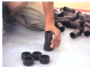
Figura 7 – Encaixe do tubo de PVC na rosca niveladora e na base
