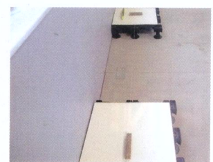
Figura 13 – Gabarito para nivelamento da fileira
