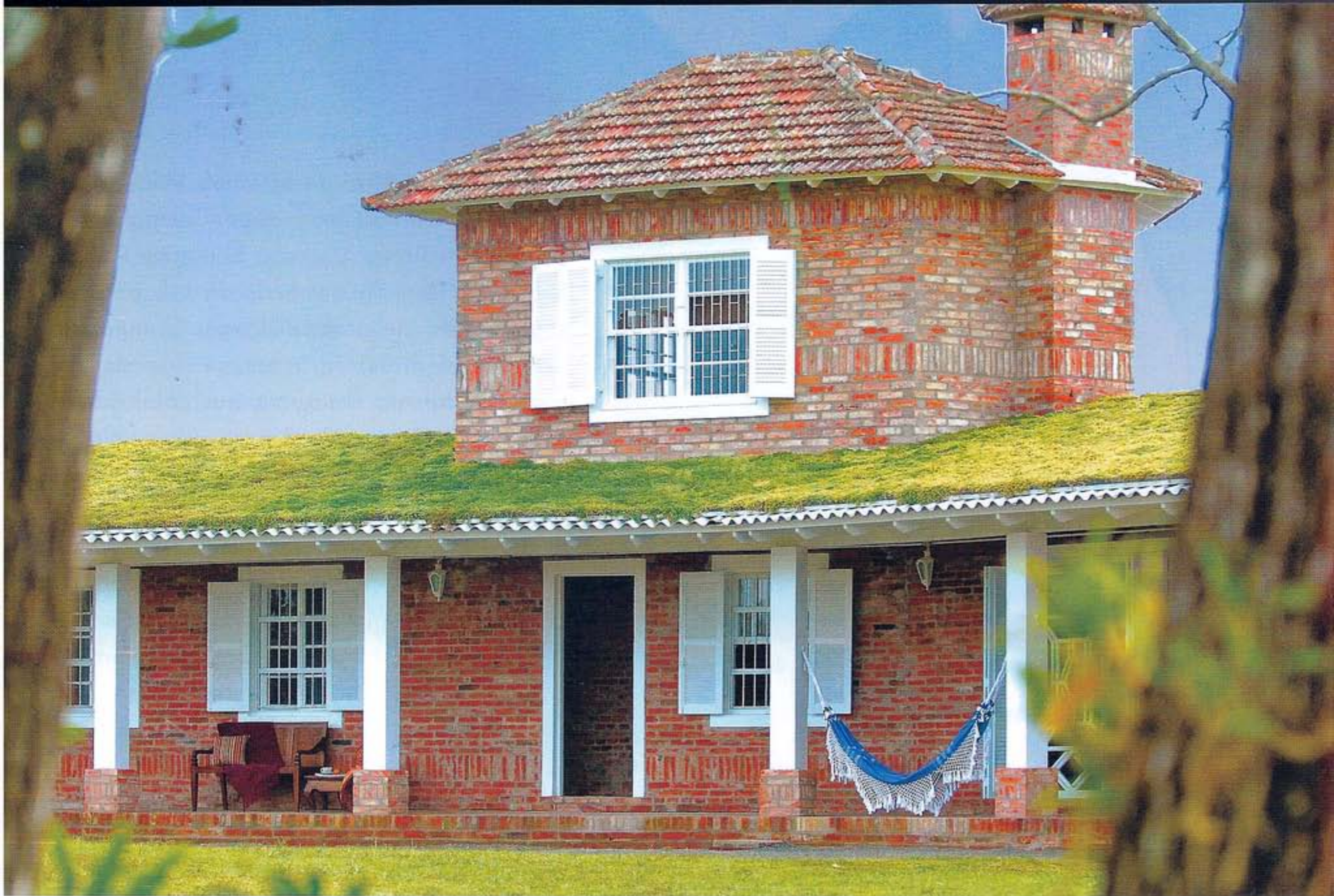
Chácara em Santa Cruz do Sul (RS), com telhado verde
