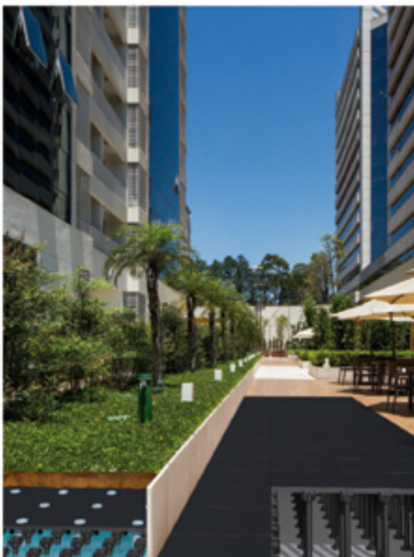
Sistema Tecgarden e piso elevado externo
