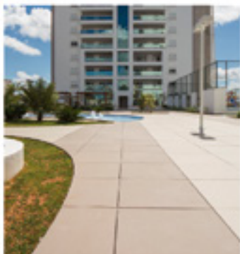
Piso elevado externo
