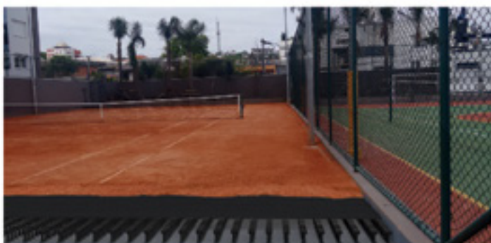
Quadra de saibro sobre piso elevado para retenção de água
