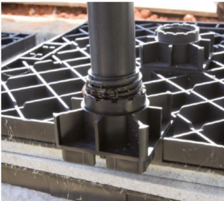
9 Para montar o pedestal é preciso aplicar cola à rosca superior da haste. Ainda será possível fazer ajustes em sua altura nas 12 horas seguintes à aplicação da cola.
