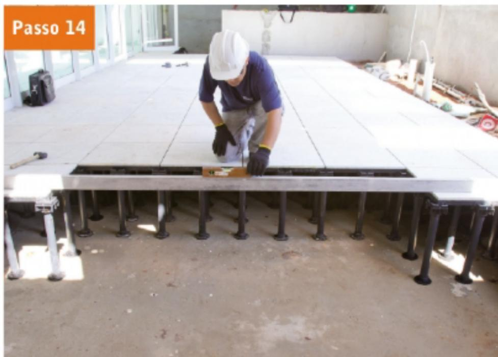
**14** Feitos os ajustes finos, a régua – junto com o nível de bolha – ajuda a verificar e manter o nível do piso entre as paredes.
