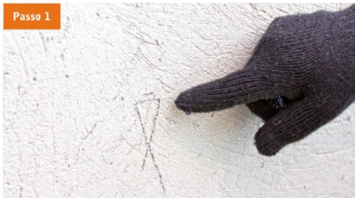
**1** É preciso marcar a cota do piso a partir de referências de nível nas paredes em todo o entorno. Estique linhas mestras laterais para definir a altura máxima que a superfície de piso elevado terá em relação à base.
